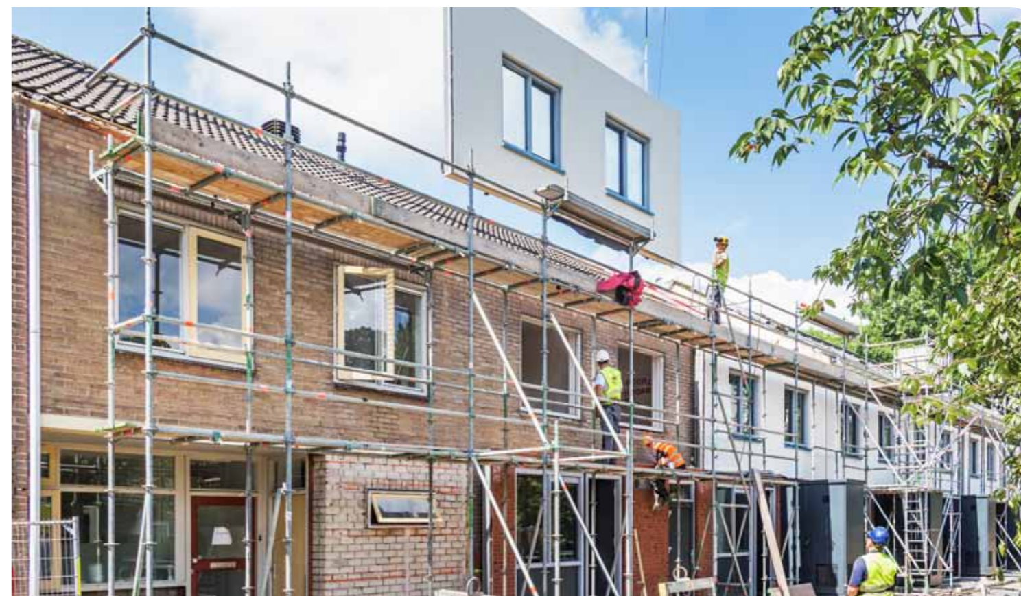
Ter illustratie: kant-en-klare gevelelementen worden op de bouw aangeleverd
