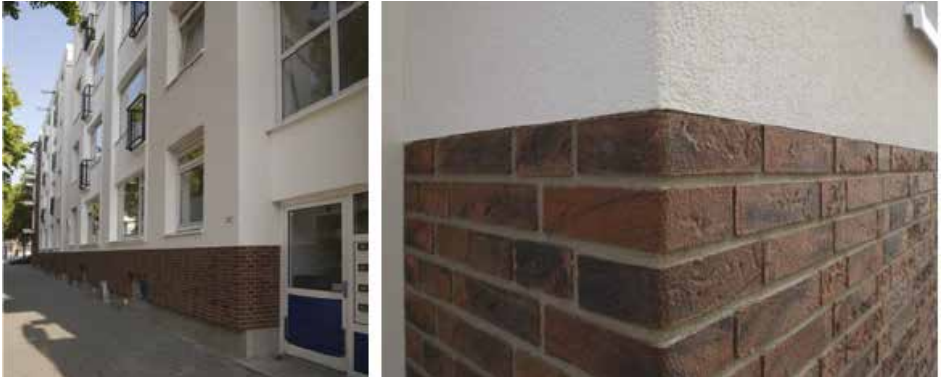
Voorbeelden afwerking buitengevelisolatie met steenstrips en sierpleisterwerk
