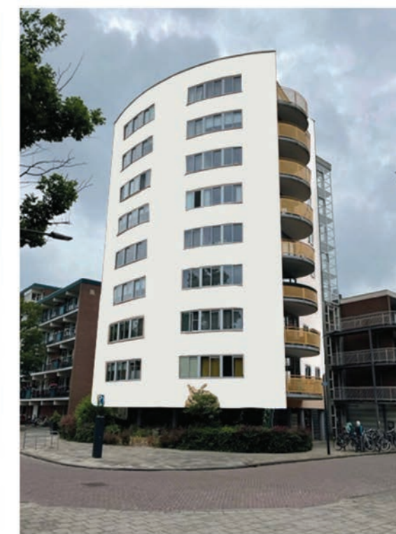
NIEUWE SITUATIE NA SCHILDEREN STUCWERK GEVEL
