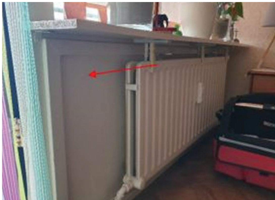
Verwijderen asbest achter de verwarming en vervangen door geïsoleerde panelen
