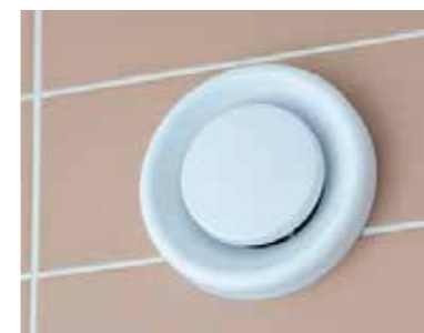
Afzuigventiel: in de keuken, badkamer en toilet
