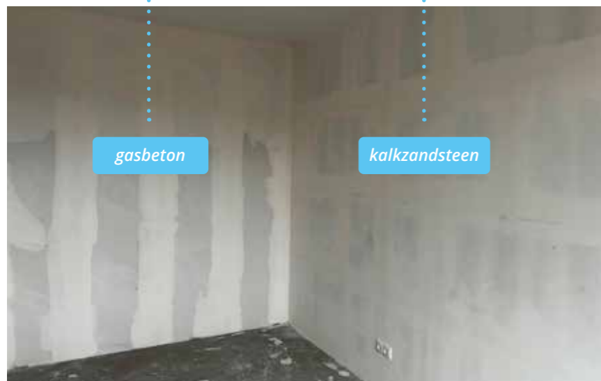
De wand links is een wand van gasbeton en rechts is een wand van kalkzandsteen.
